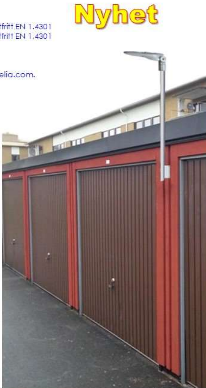
Montage på plåtvägg .
